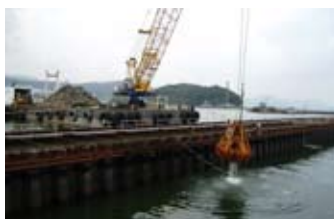
▼ 変位回復のための海側捨石撤去（8月18日撮影）
