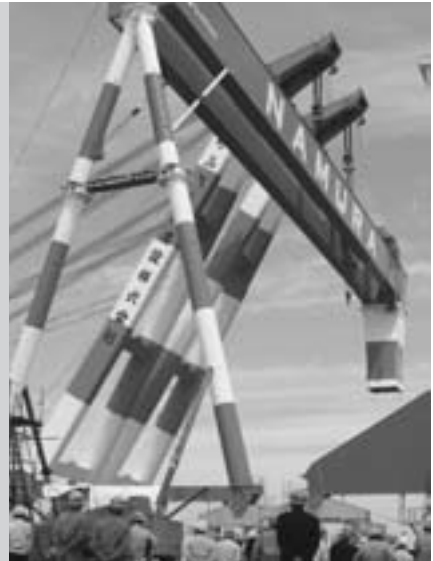
8000トンの重量を吊り上げるコライアス（巨人）クレーン
