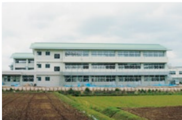
着々と建設が進む国見中学校校舎
