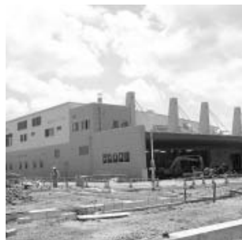
建設中の新給食センター
