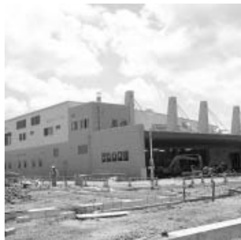
建設中の新給食センター
