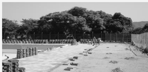
国見台徒渉プール改修状況
