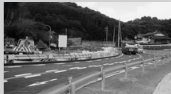
国道202号 災害復旧道路（府招上）
