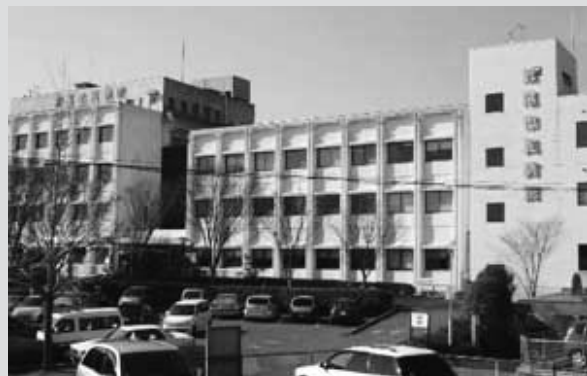
荒尾市立市民病院
