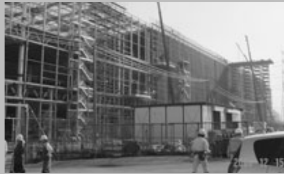
着々と建設が進む(株)SUMCO第5工場
