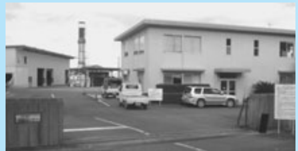
環境センター（黒川町）
