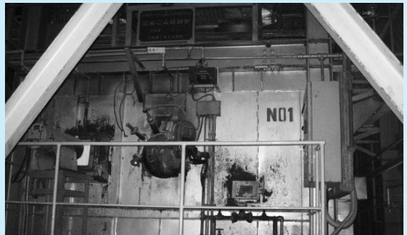
1号炉焼却炉本体耐火物
