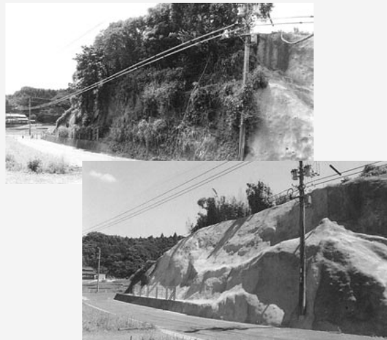
里地区での落石防止工事（着工前・上）（成工・下）
