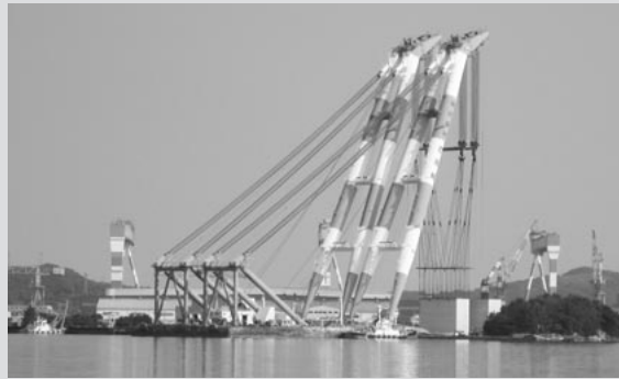
ケーソン据付
