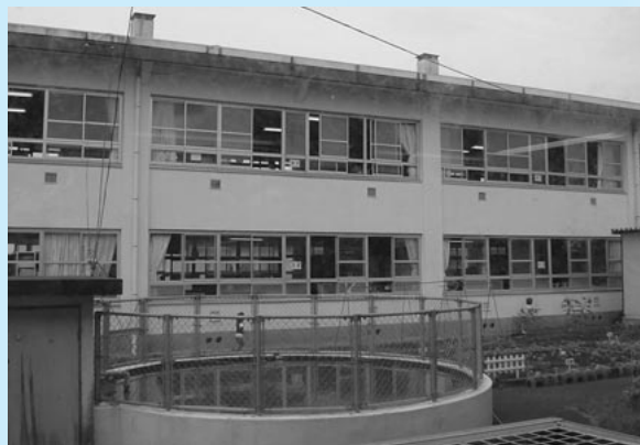
耐震強度診断で改築が必要となった二里小学校校舎
