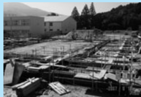
建設中の国見中学校屋内運動場
