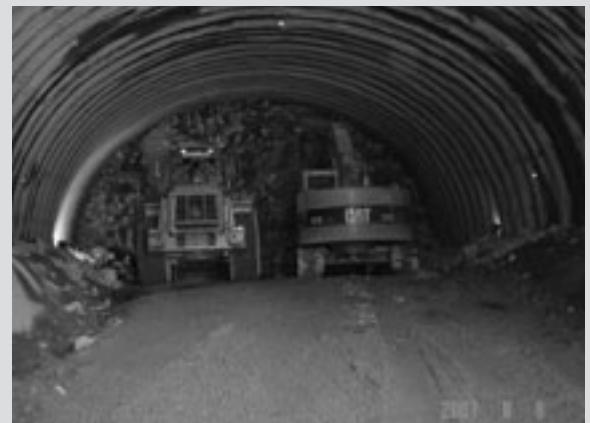
工事中の養母田トンネル
