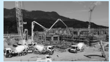
建設中の新病院
