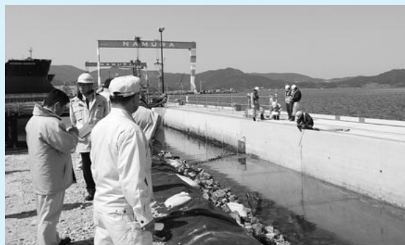
七ツ島コンテナターミナル
