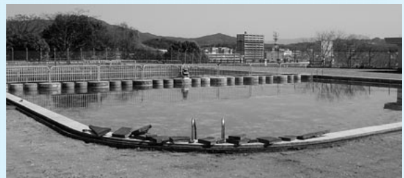
補修中の徒渉プール
