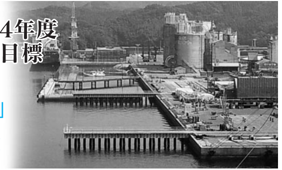
整備中の伊万里港全景
