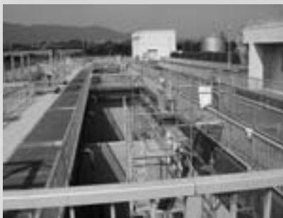
伊万里浄化センター
