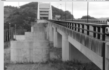
伊万里湾大橋上部工未施工箇所
