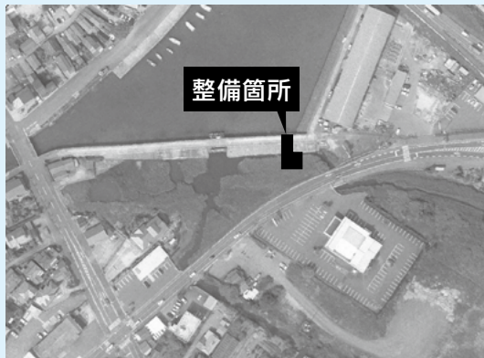
楠久津地区浸水対策整備箇所
