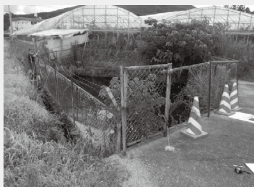
補修される防火水槽
