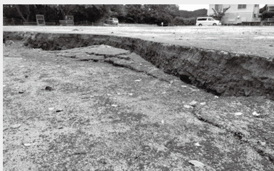
農林地崩壊現場
