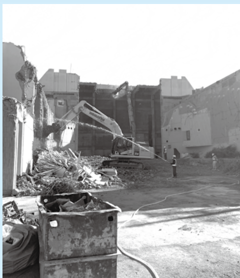
解体中の市民会館本館
