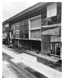
大坪小学校木造3棟舎
