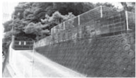
安全確認中のブロック塀(伊万里保育園)
