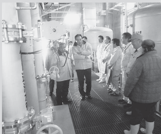
現地視察 有田川浄水場
