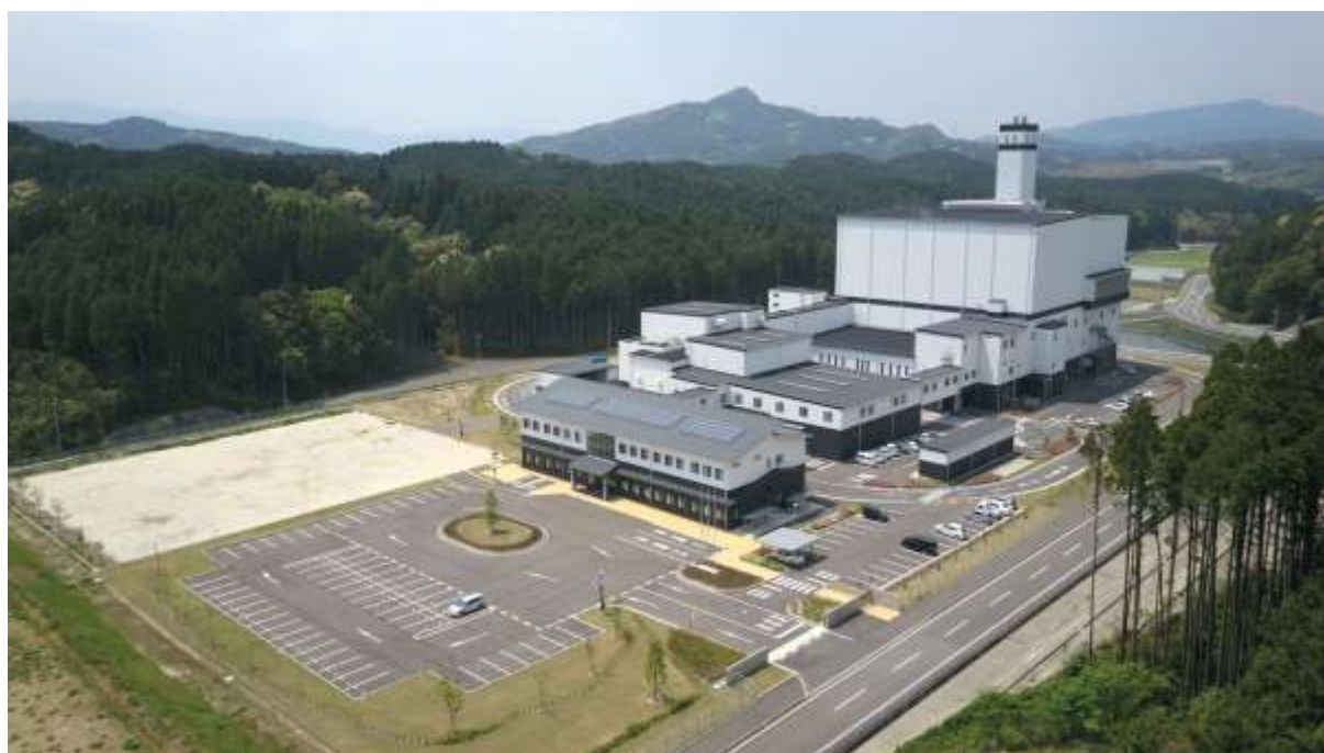
図3-10 さが西部クリーンセンター外観 (マテリアルリサイクル施設も同様)
