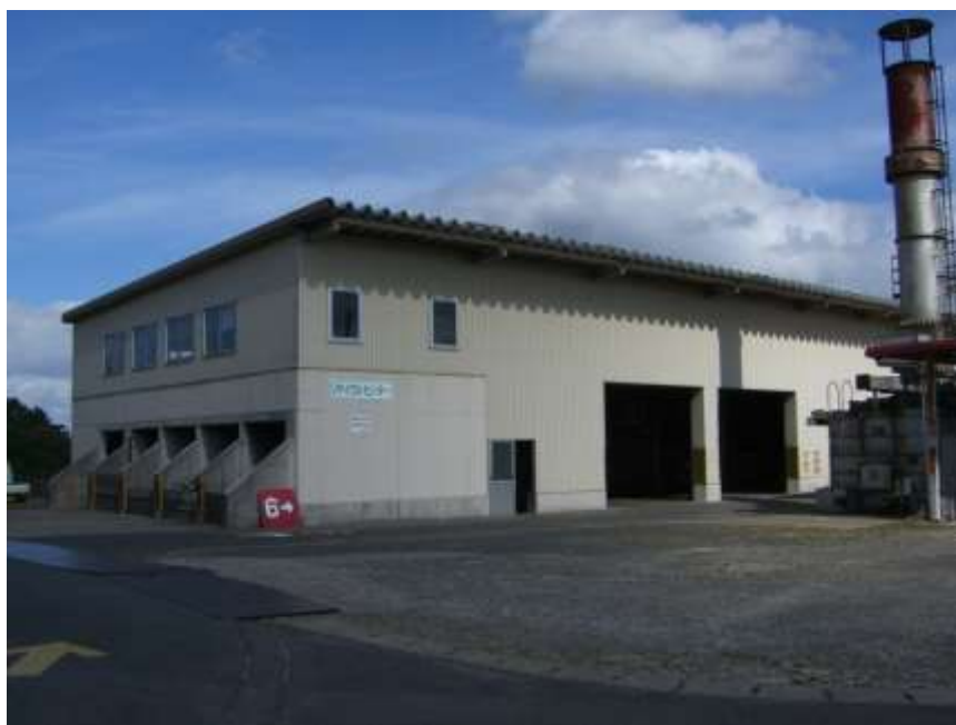
図3-11 伊万里市環境センター(黒川町)リサイクルセンターの外観
