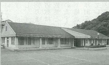
新事務所となる九州農政局伊万里開拓建設事業所跡
