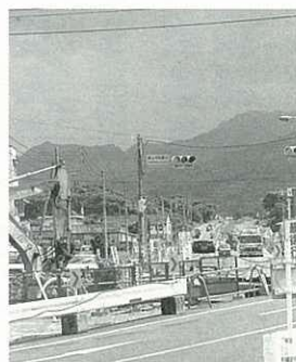
整備が進む国道204号長浜付近の様子
