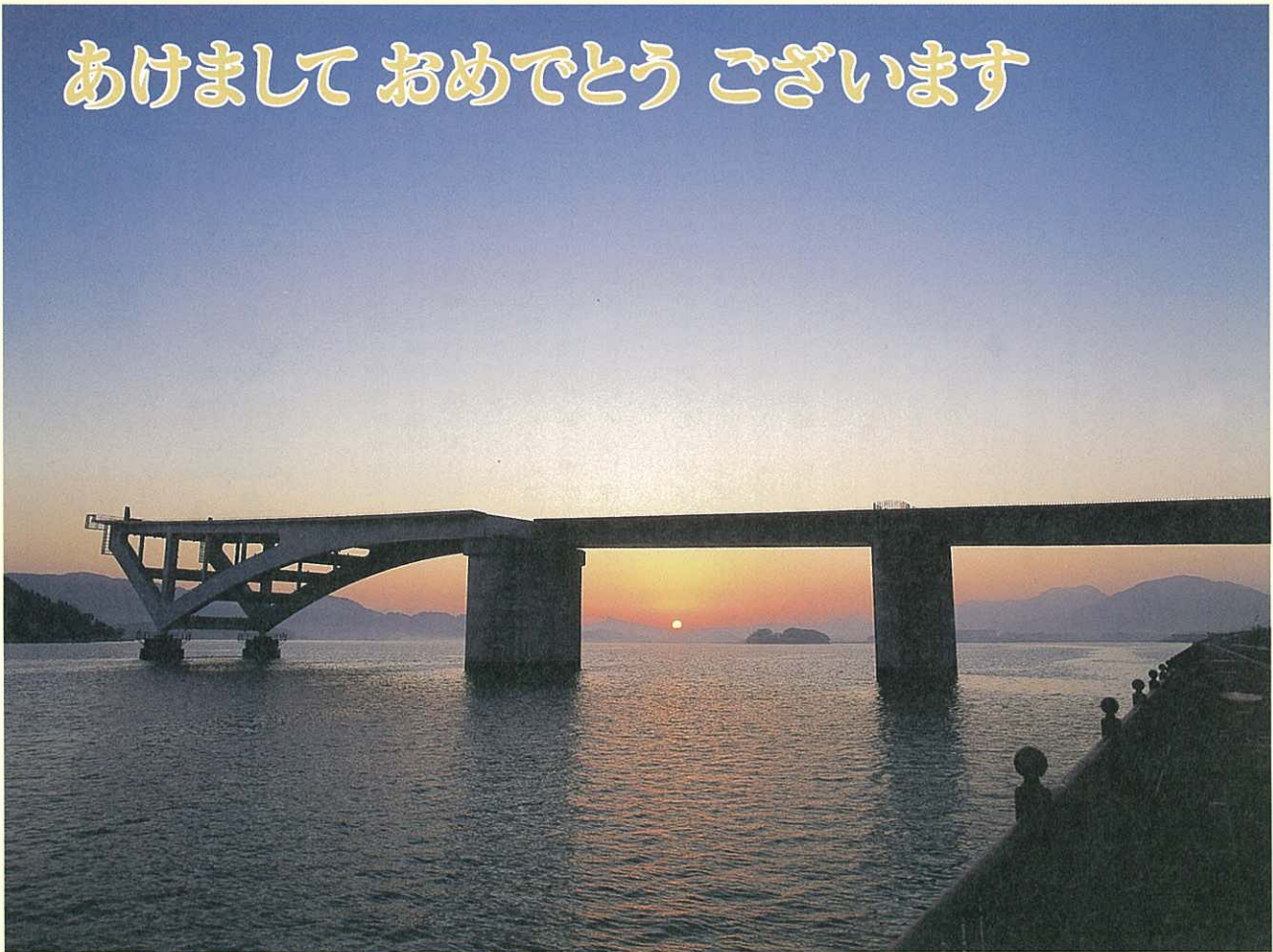
朝日に映える建設中の伊万里湾大橋
