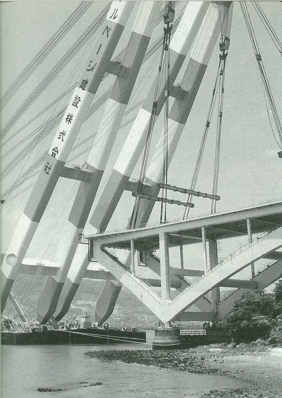
(6/11 伊万里湾大橋海上架設)
