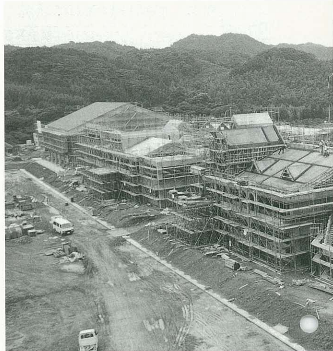
建設が進む青嶺中学校
