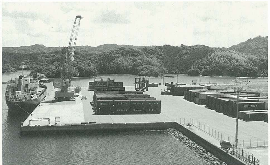
金曜日入港のビーナス号(1988ト)の積載能力は、20フィートコンテナ換算で106本。月曜入港のジュピター号(2217ト)は、20本多い126本を積み、釜山港から伊万里港、広島港を回ります。
