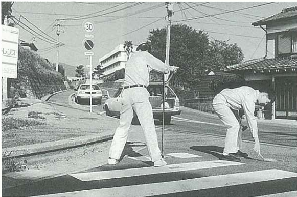
8月25日～26日 上水道12時間断水開始。市職員が配水管のバルブの開閉作業を行ないました。
