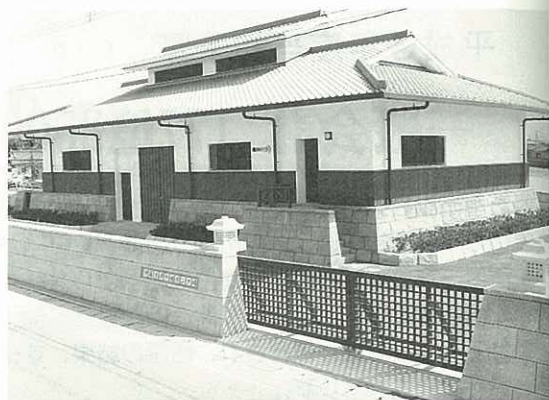
◎御番所風に建てられたポンプ場
