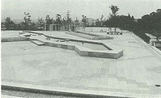
○浄水場跡の“水の広場”円造寺公園。今年度子どもの広場を整備して完成します。
