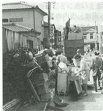
○粗大ゴミの積み込み(元町)
