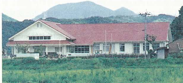
○完成した南波多公民館。屋根と歩道はワインカラー
