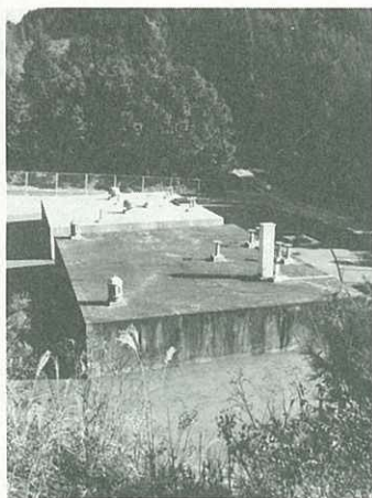
立川に建設された配水池
