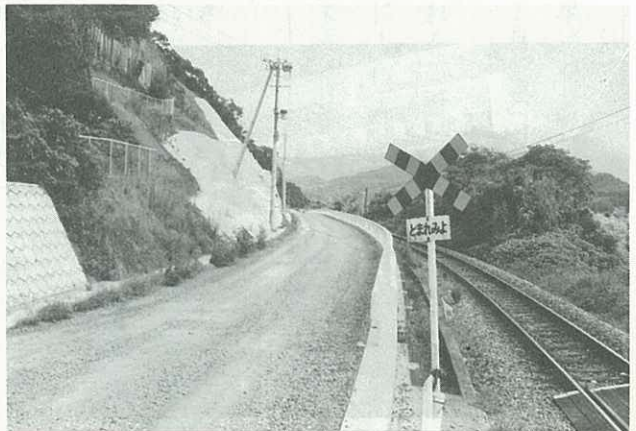
④ 改良された市道駒鳴～立川線 (延長260m)
