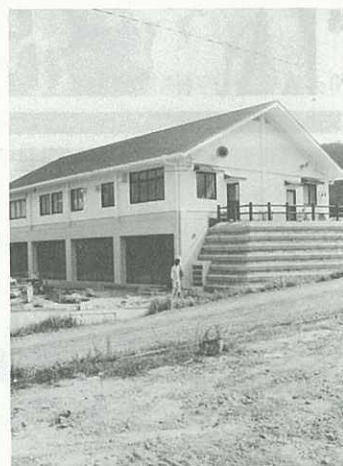
改築中の管理棟
