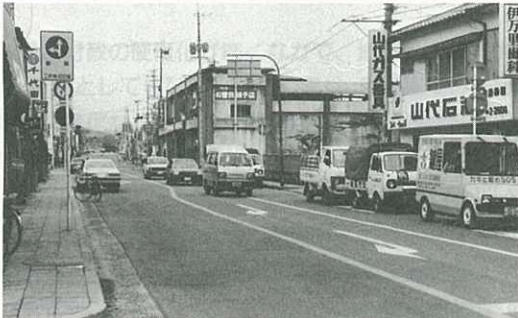
▲公共下水道は、本町汚水幹線の管きよ埋 設を実施します。
