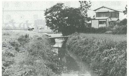
▲河川改修事業では、常襲浸水地帯の解消 を図るため準用河川改修事業で昨年に引き 続き川東川（写真）及び長浜川の整備を実 施します。
