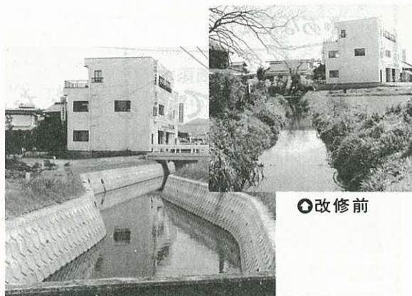
●長浜川河川改修 昭和60年度施工 119橋 2,310万円
