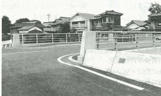
●改築された楠久津橋 7,400万円
