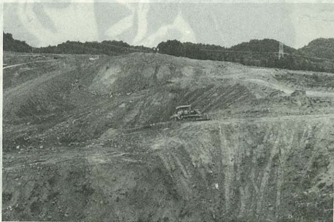
進む樹園地造成（波多津町田代地区）
