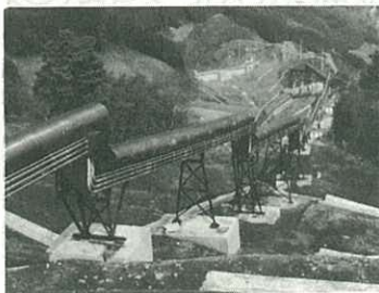
▲完成した不燃物埋立処理施設（黒川町立目）
