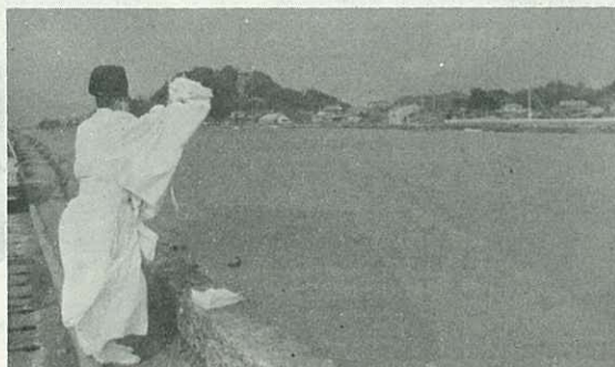
▲伊万里大橋の起工式で伊万里川をお払い
