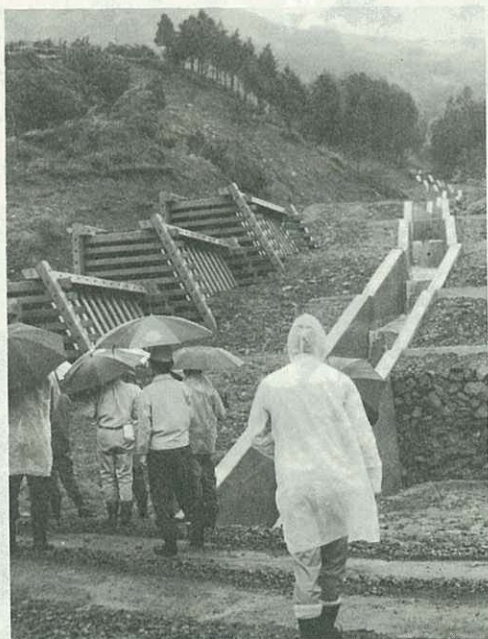
▲ 大久保の小岩2坑ボタ山の改修工事
