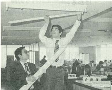
▲省エネでけい光灯を削減（市役所）
