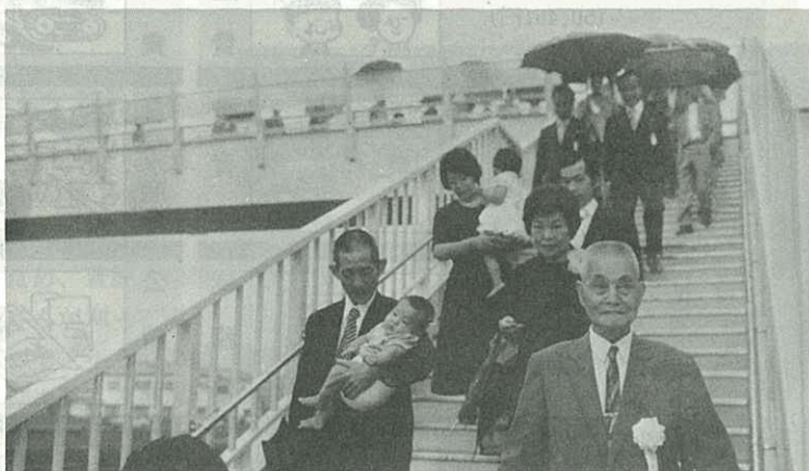
▲伊万里駅裏と市街地を結ぶ「蓮池跨線橋」が完成
