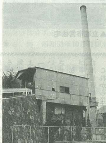
▲山代町楠久にあるゴミ焼却場
