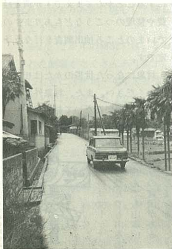
▶舗装完了した江湖辻～川東線◀
