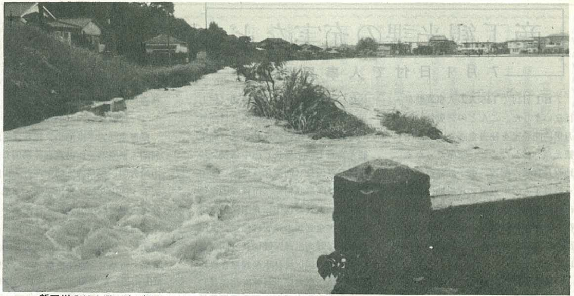
新田川のはん濫で水びたしになった立花町金谷一帯（国道バイパス筑肥線立体橋工事現場付近から写す。）
