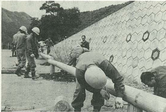
▷古い電柱で平均台をつくる九電の人たち◁
