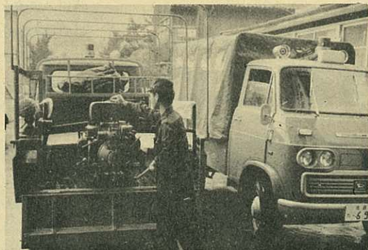
▶松浦町と東山代町に配車したポンプ積載車◀
