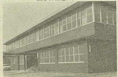
完成した税務署の建物
